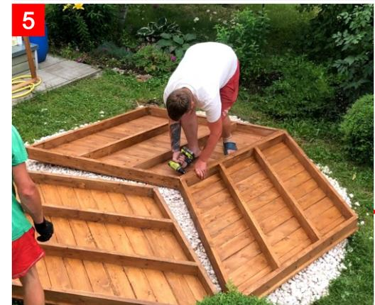
Для удобства монтажа секции пола переворачивают лицевой частью на заранее подготовленную площадку.
