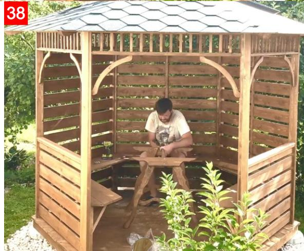
2 этап: Переворачиваем круглую столешницу на собранное подстолье и при помощи уголков (4 шт) соединяем саморезами 3,5x20 (8 шт)
