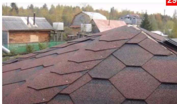
Крепление кровли производится с помощью молоткового степлера на скобы 8-10 мм или оцинкованное толевые гвозди 20 мм
