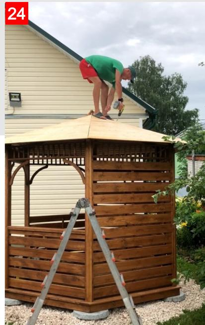
**В целях избежания растрескивания досок в момент прикручивания саморезов сверлится отверстия D 4 мм. с краю каждой доски. (рис 25)**
