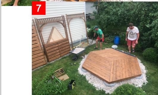
Расположение бетонных плит
